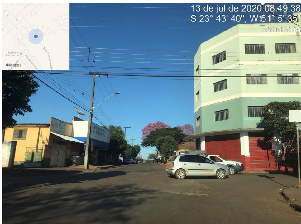
Imagem 10: Vista do fim do trecho que será recapeado, na Rua Ancião Vicente Subtil de Oliveira, visualizando o cruzamento com a Rua Arlindo Pereira de Araújo.
