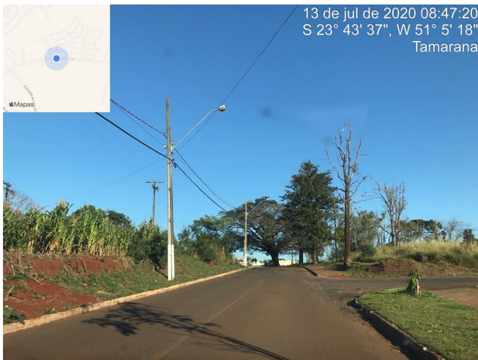
Imagem 03: Vista da extensão da Rua Ancião Vicente Subtil de Oliveira, onde na esquerda da foto está as vias locais para acesso à Loteamentos perpendiculares e paralelos à esta.
