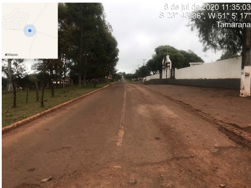
Imagem 01: Vista do início da Rua Ancião Vicente Subtil de Oliveira, visualizando sua extensão, que será recapeada, onde na esquerda da foto está o Cemitério Municipal.
