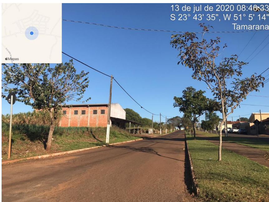
Imagem 02: Vista da extensão da Rua Ancião Vicente Subtil de Oliveira, onde na esquerda da foto está as vias locais para acesso à Loteamentos perpendiculares e paralelos à esta.
